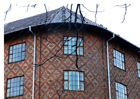
Renovering af Linoleumshuset, København N
